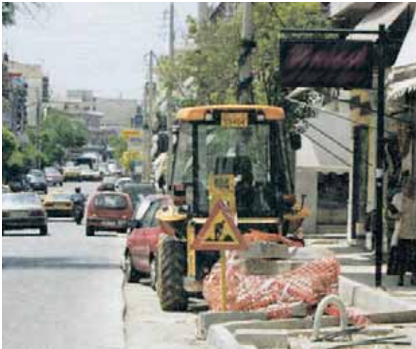
Εικόνα 31.1: Κατασκευή νέων πεζοδρομίων
